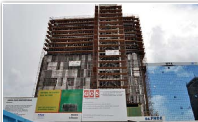
22.10: prédio do FNDE em reforma
