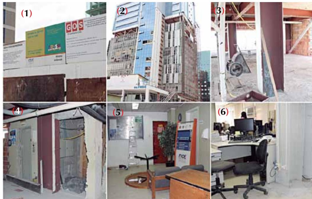
Fotos tiradas em 16/09: (1) placas sem informações da obra/ (2) fachada do prédio com vários andares sem janelas/ (3) equipamento e restos da construção abandonados/ (4) fiação e encanamento expostos/ (5) escada de incêndio interdita/ (6) estações de trabalho amontoadas
